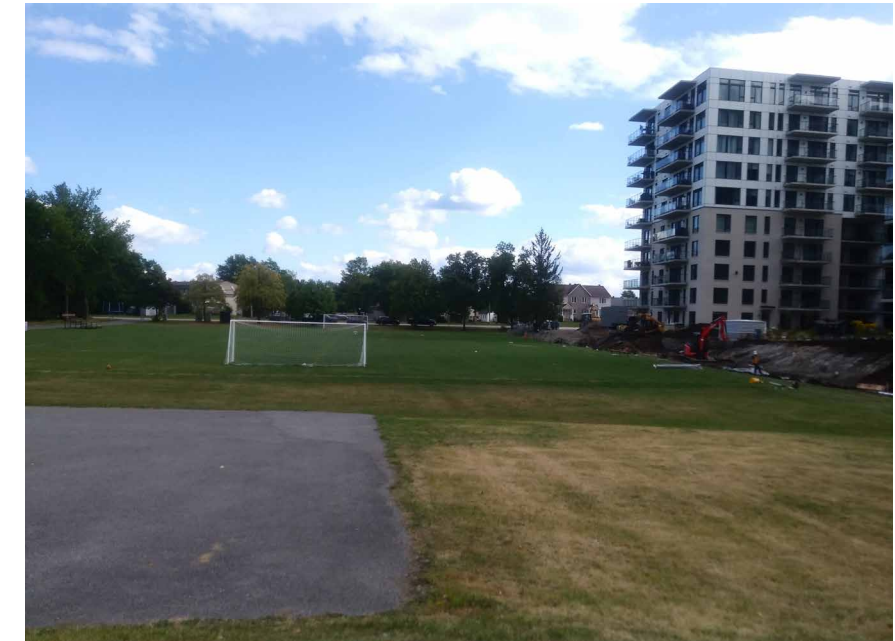
TERRAIN DE SOCCER EXISTANT ET BÂTIMENT RÉSIDENTIEL EN CONSTRUCTION
