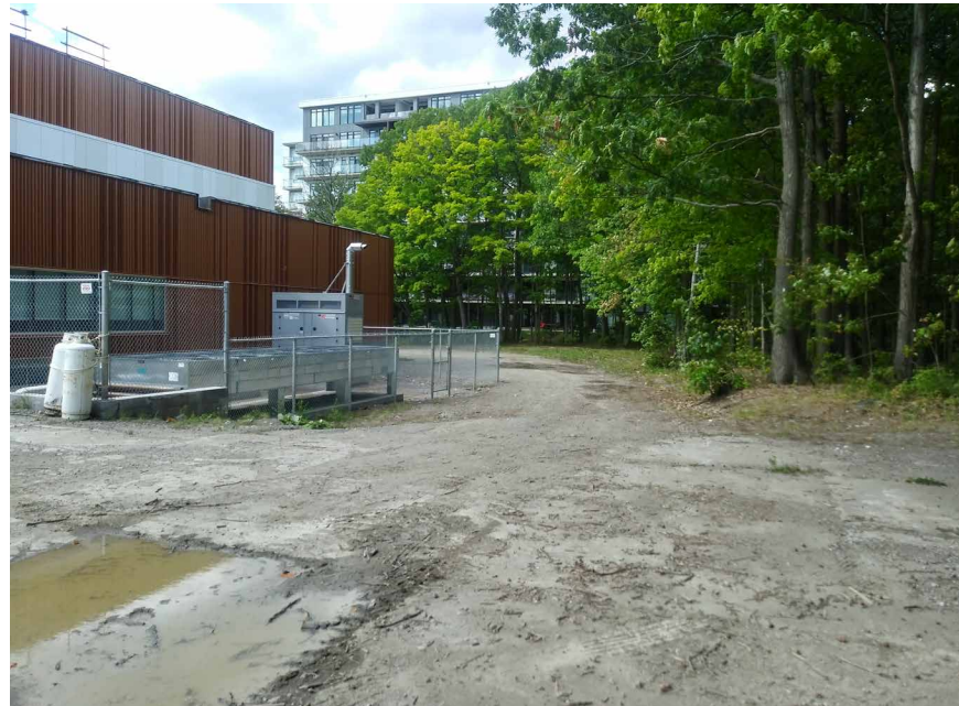
CÔTÉ EST DU BÂTIMENT ET ACCÈS MÉCANIQUE
