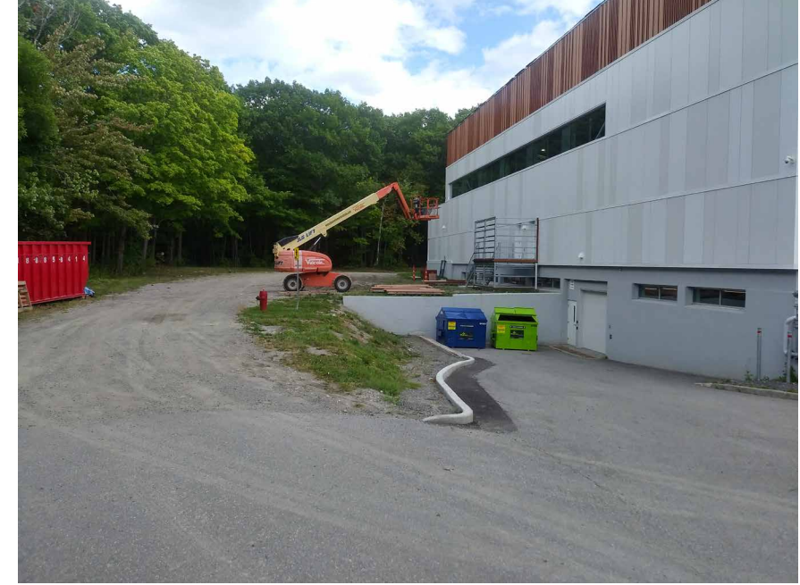
CÔTÉ NORD DU BÂTIMENT
