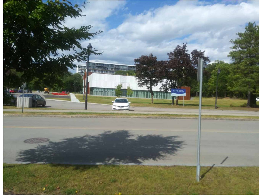
CÔTÉ SUD DU BÂTIMENT ET STATIONNEMENT À DÉMOLIR
