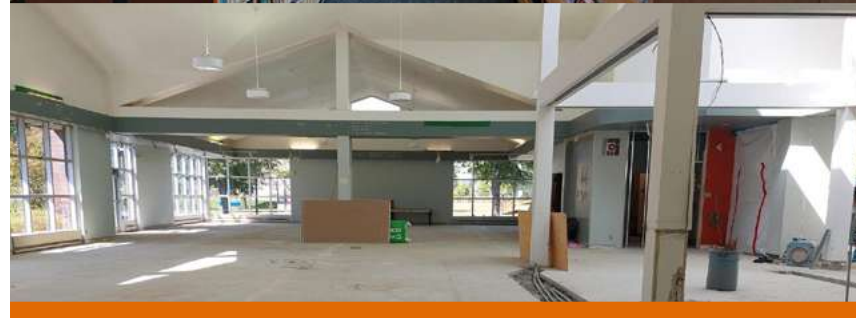
Une partie de la bibliothèque avant et durant les travaux.
