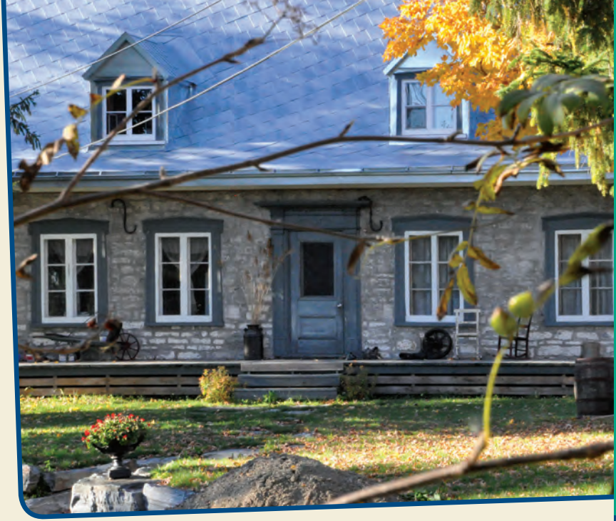
La maison Quézel construite en 1750
